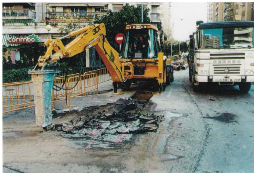
DEMOLICIÓN MECANICA DE PAVIMENTO ASFALTICO
