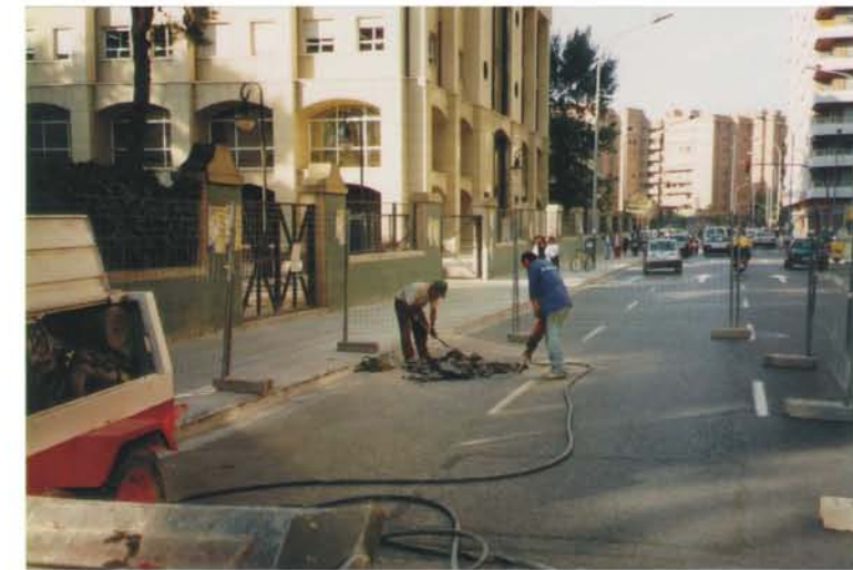
DEMOLICIÓN MANUAL LOCALIZACIÓN DE SERVICIOS
