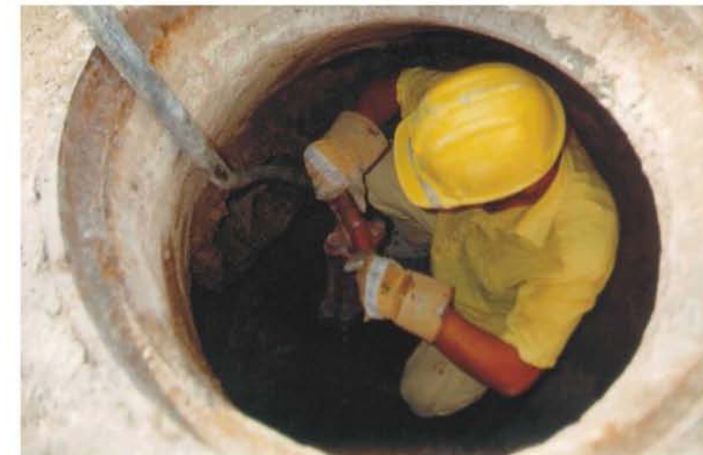
DEMOLICIÓN MANUAL EN INTERIOR DE POZO
