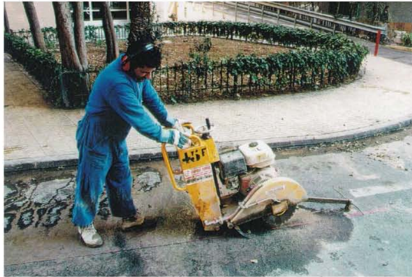
CORTE DEL PAVIMENTO ASFALTICO
